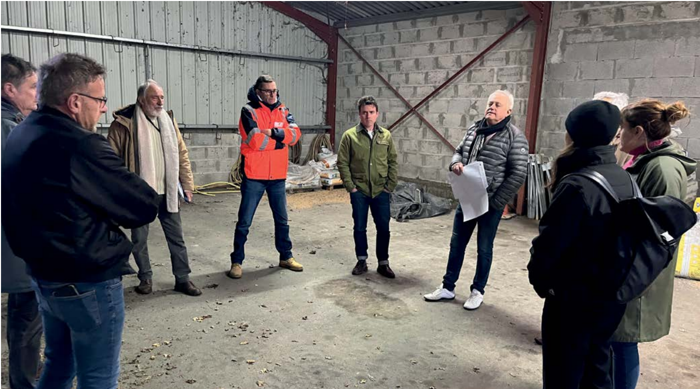
Bénévoles, partenaires institutionnels et professionnels se réunissent régulièrement sur le chantier du garage.
